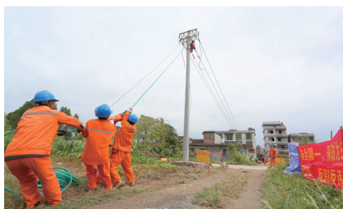
玉林市福绵区福西村1号公变改造正在有序建设中。
