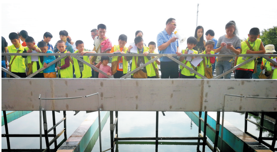
参观平流沉淀池
