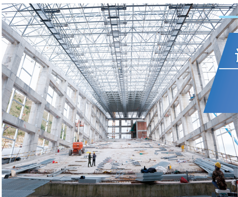
▲在滑雪馆内,造雪设备已进场安装。
