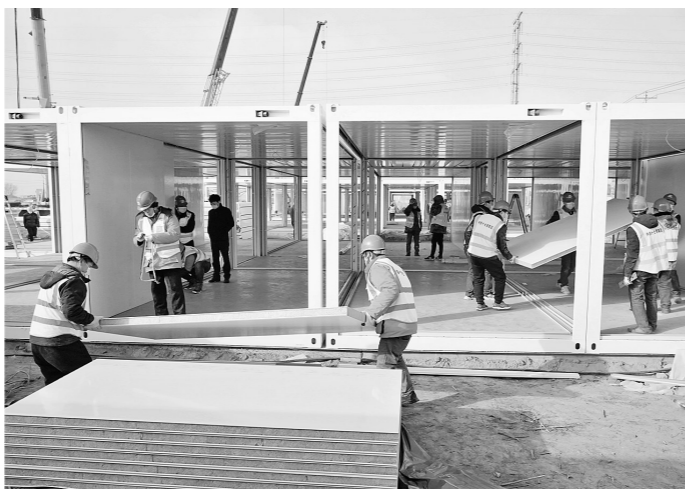
▲1月15日,工人在石家庄黄庄公寓隔离场所项目工地安装集成房屋。
