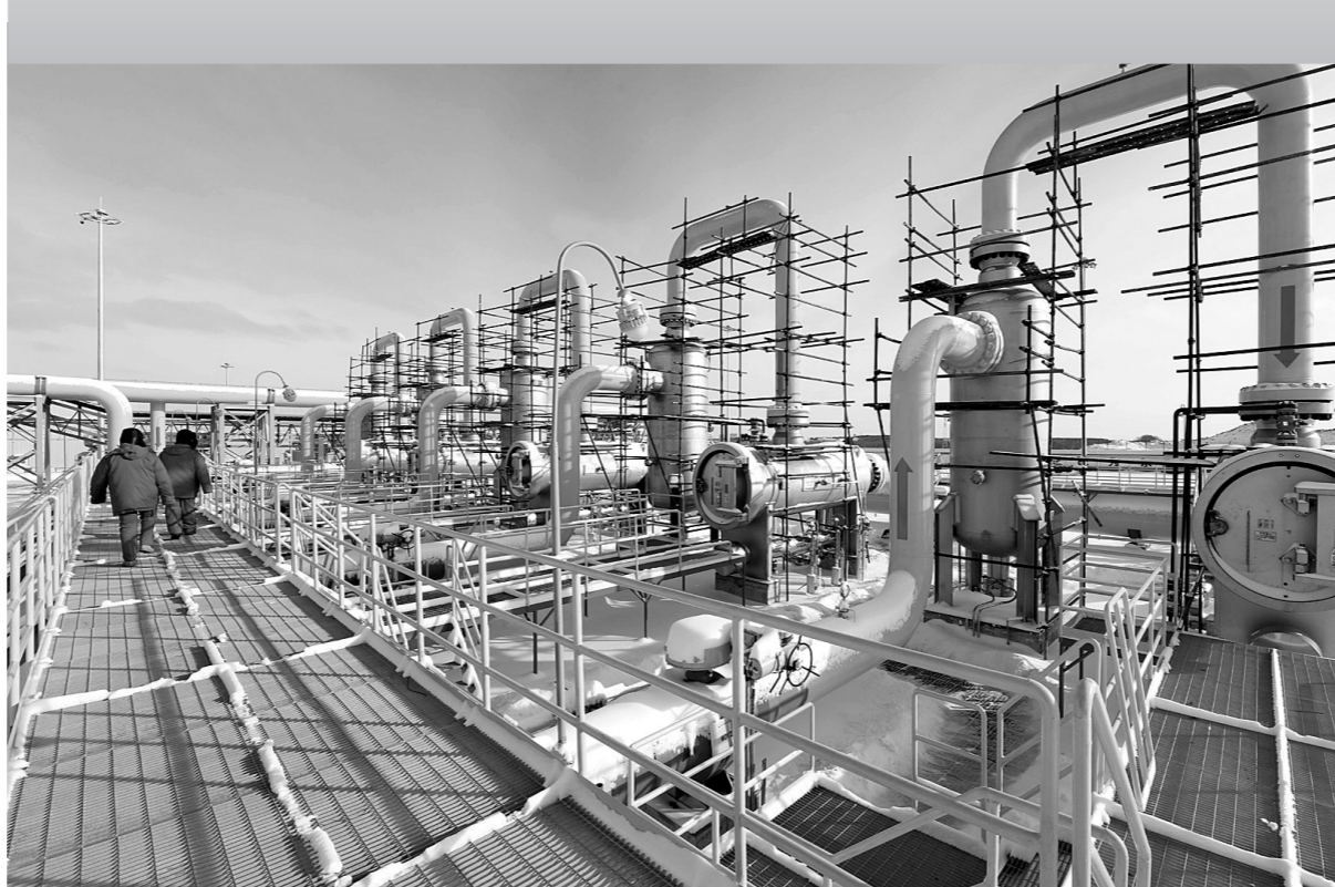
▲工作人员在中俄东线天然气管道北段黑河首站场区巡检(11月19日摄)。
